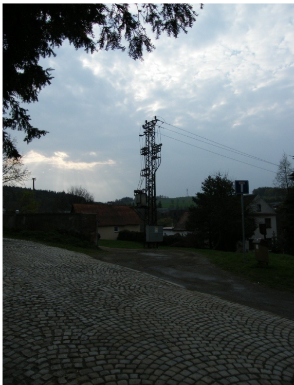
Nevhodné prvky veřejné TI
