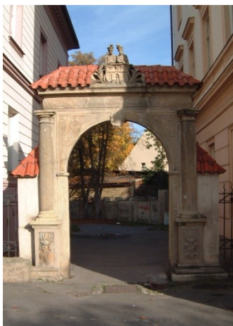
Vstup do městského parku tvořený Vybouraným portálem domu č.p. 63
