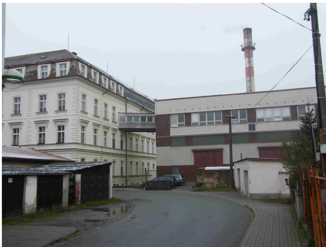
Nevhodný objekt kotelny s napojením na ZŠ Mánesova
