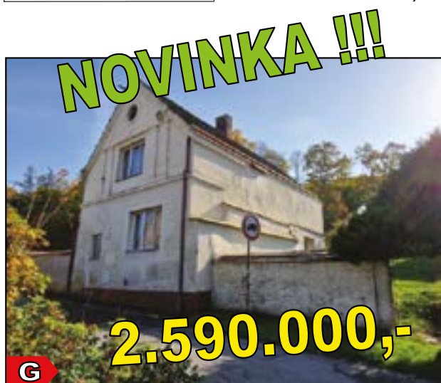
RD Stříbro, Partyzánská ul.
