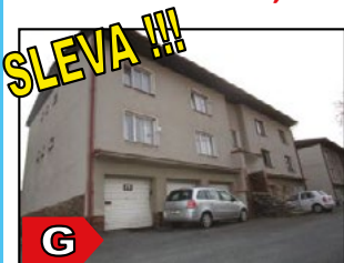
Byt 3+1+L s garáží Lestkov
